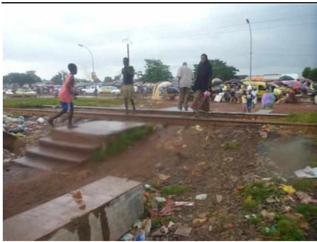
Figure.1.2 Passage piéton au niveau du marché Sahara et fondation de la future passerelle piétonne
