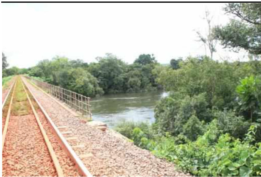
Figure 7.21 Premier pont sur la Tinguilinta
