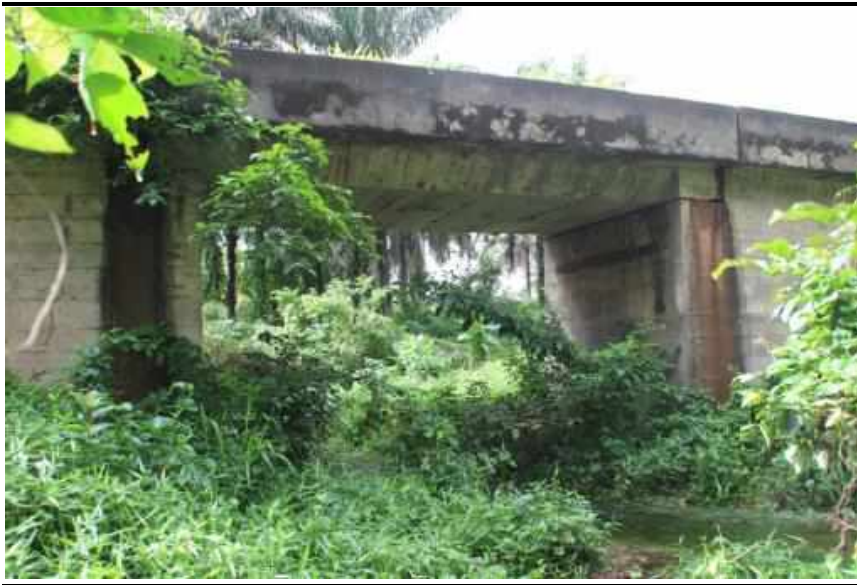
Figure 7.23 Pont sur petit cours d'eau vers Fodé Conteah
