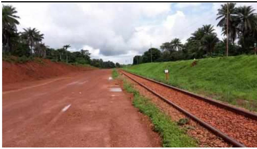
Figure 7.33 Paysage avec deuxième voie en construction (vers PK27)
