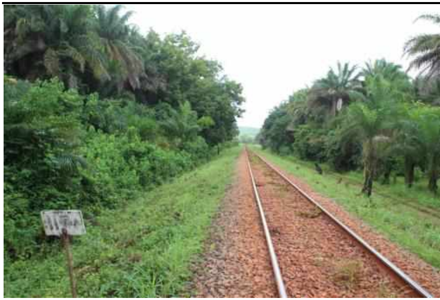
Figure 7.51 Palmeraie autour du PK117
