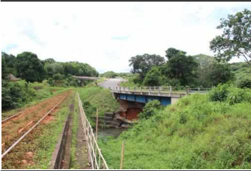
Figure 7.22 Pont sur la rivière Kéwéwol
