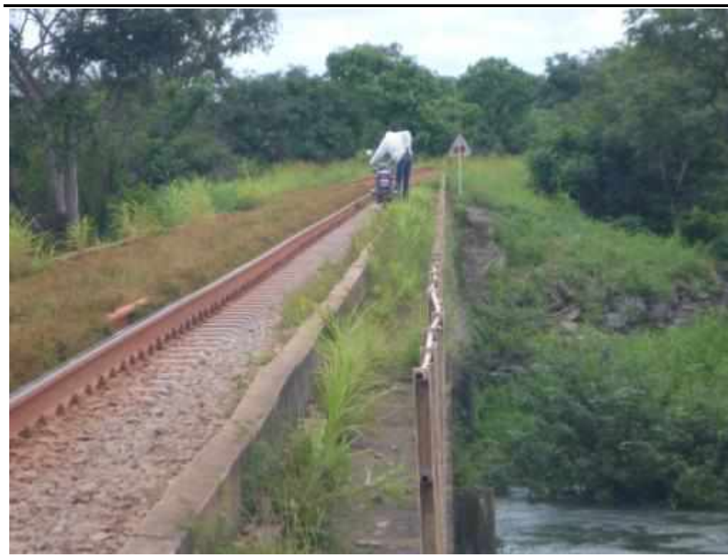
Figure 8.8 Pont ferroviaire sur la Tinguilinta, Tiankoun Rail
